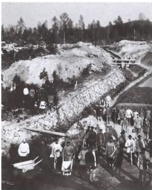
Строители железной дороги на дренажных работах
