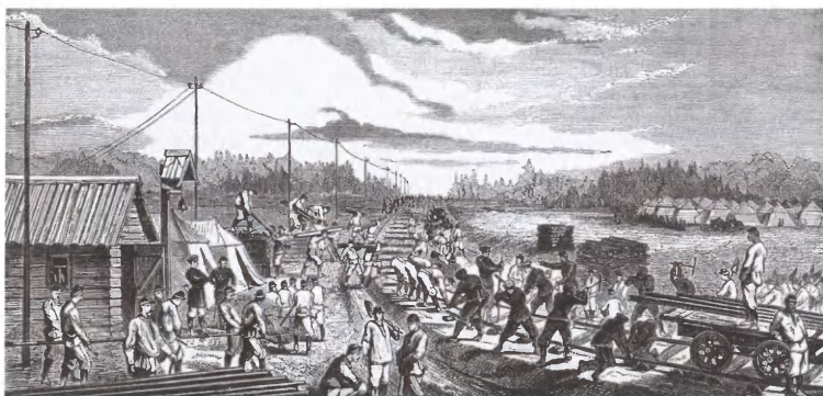
Укладка рельсов. Гравюра Л. А. Серякова
