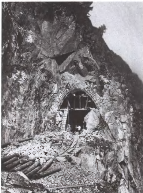
Строительство Кругобайкальской железной дороги. Постройка тоннеля № 38 на 72 версте. Начало XX в.
